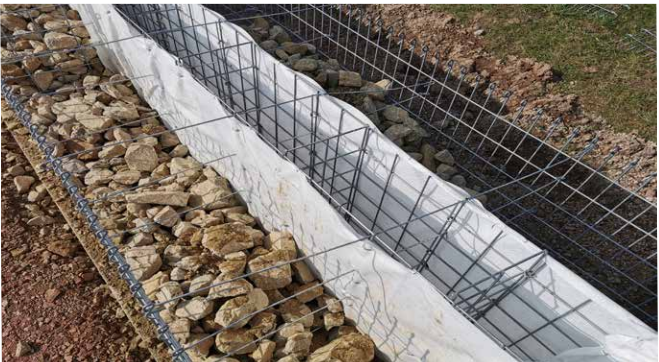
Bild: Teilweise befüllte Silent R® -Lärmschutzkörbe, Foto: Max Friedhoff
