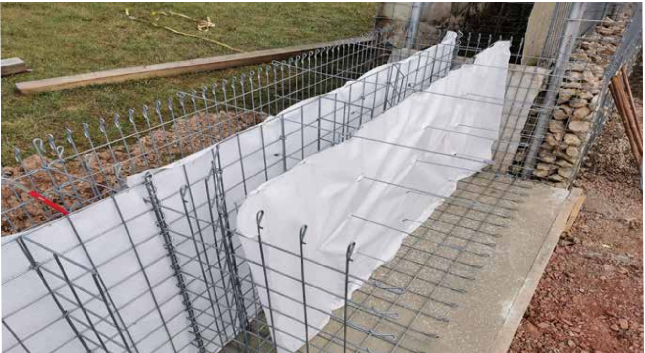
Bild: Montage der ersten Lage, Anbindung der Schalungsgitter, Foto: Max Friedhoff
