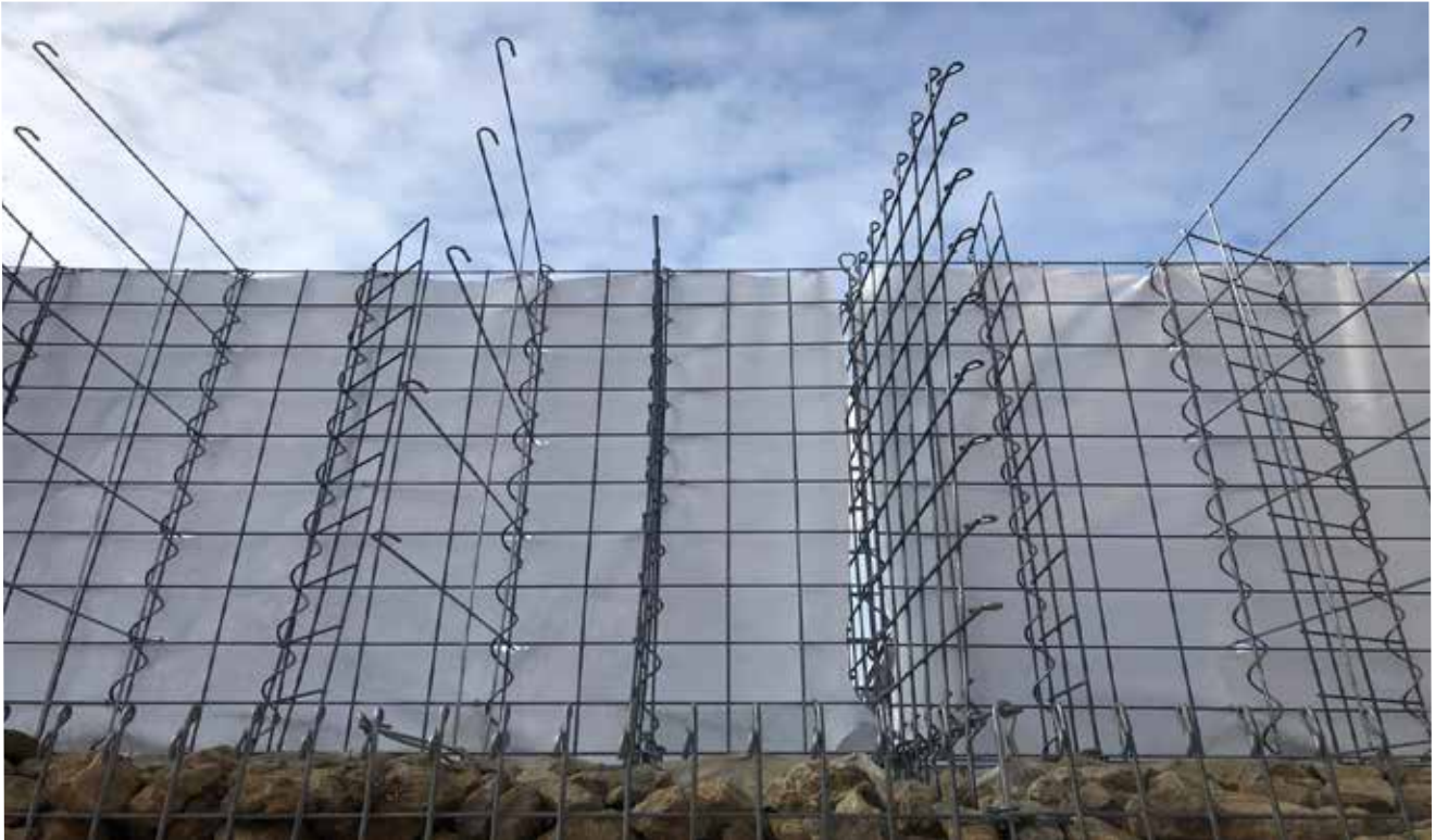
Bild: Montage der zweiten Lage, Foto: Max Friedhoff
