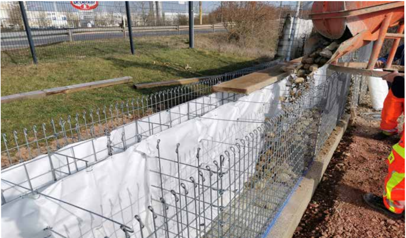
Bild: Befüllung der ersten Lage mit Steinen, Foto: Max Friedhoff
