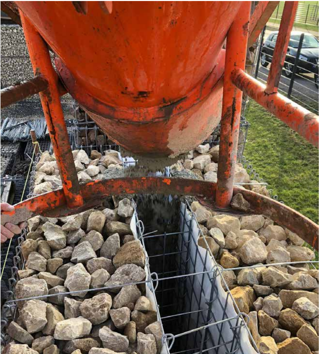
Bild: Einbringen des Betons, Foto: Moritz Friedhoff
