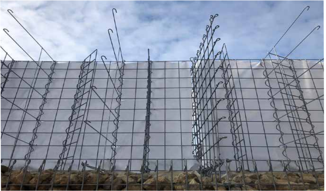
Image : Assemblage de la deuxième couche, photo : Max Friedhoff
