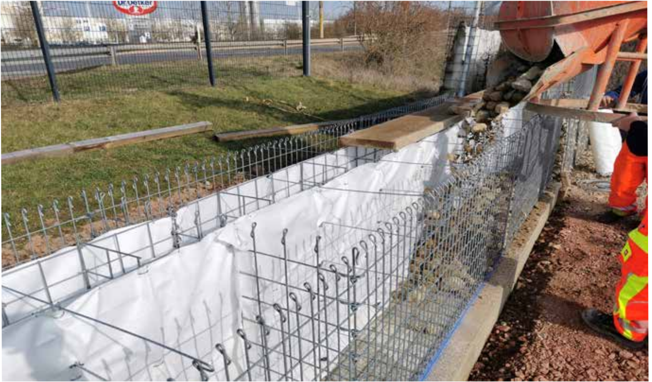
Image : Remplissage de pierres de la première couche, photo : Max Friedhoff
