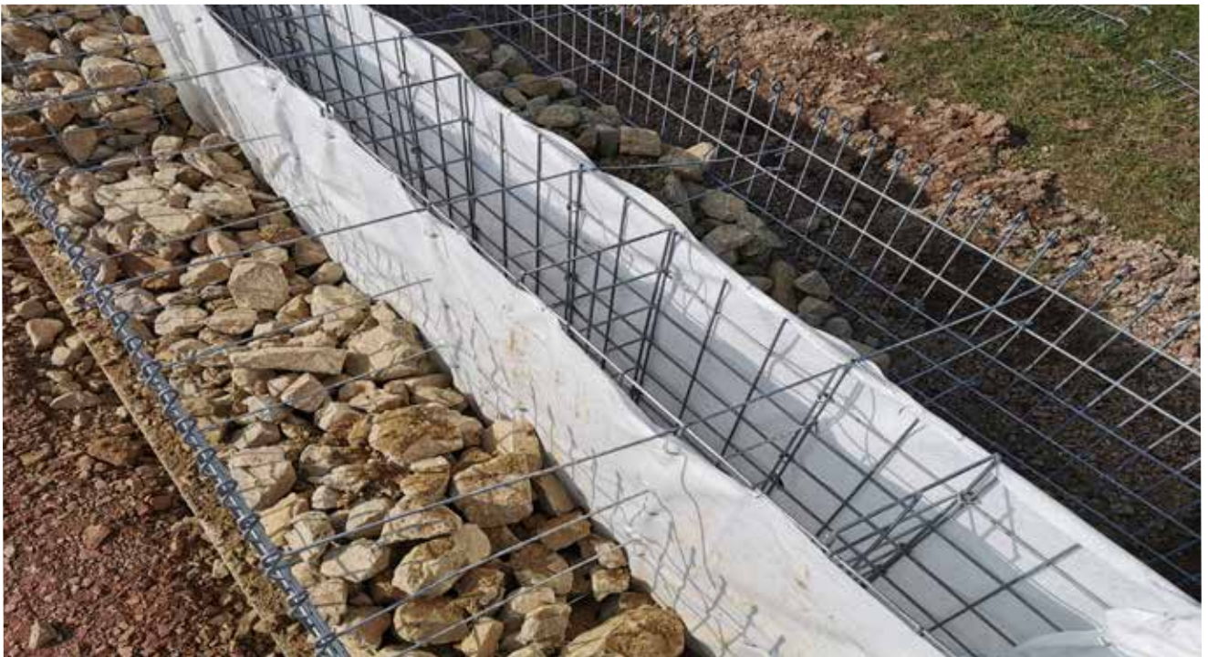
Image : Module anti-bruit Silent R® partiellement rempli, photo : Max Friedhoff
