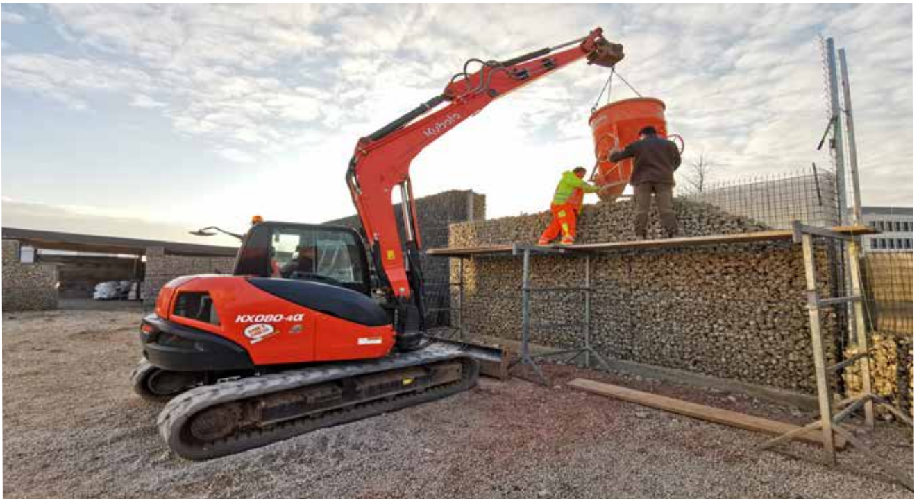
Image: Silent R® presque complètement rempli - échantillon de mur sur notre terrain, photo : Max Friedhoff
